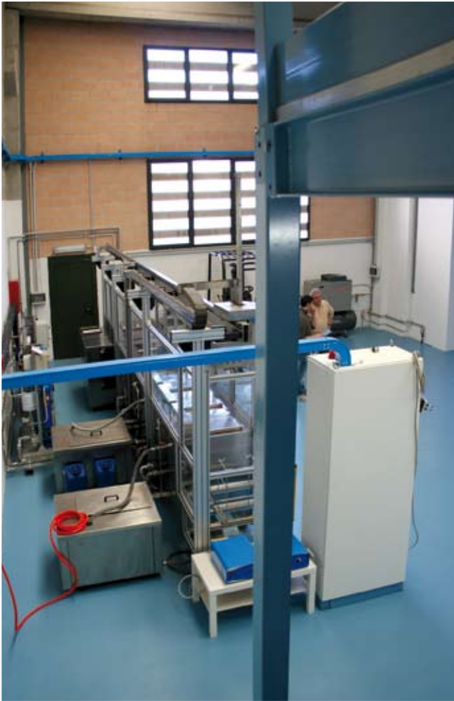
11 - L'impianto di lavaggio ad ultrasuoni dei pezzi prima del trattamento metallorganico.
